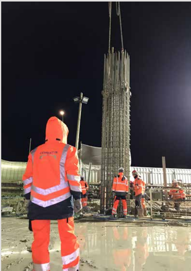
Photographie de l'équipement d'une paroi moulée.
