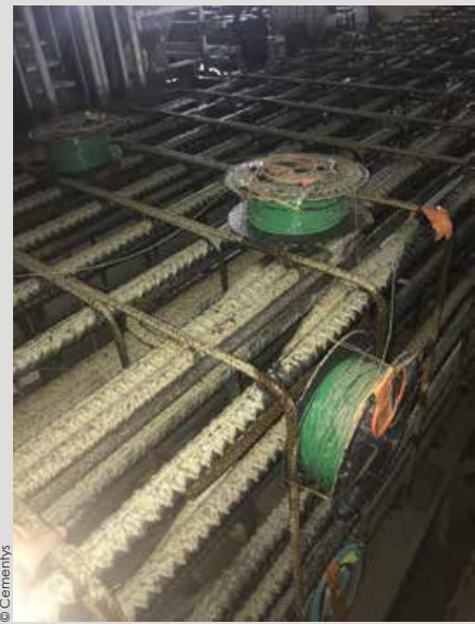
Photographie de l'instrumentation d'une cage d'armature de paroi moulée.
